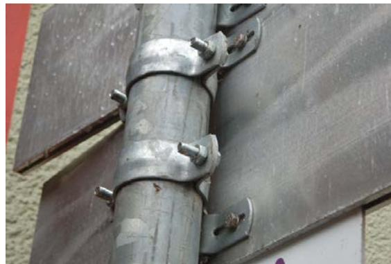
Abbildung 7-6 Pfeilwegweiser mit Stahlbandschellen befestigt
