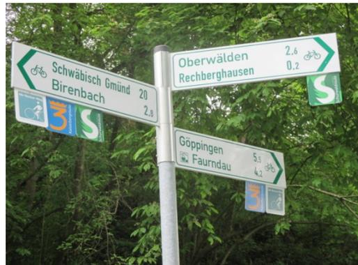
Abbildung 7-5 Tabellenwegweiser mit Rohrschellen an Standardmast befestigt
